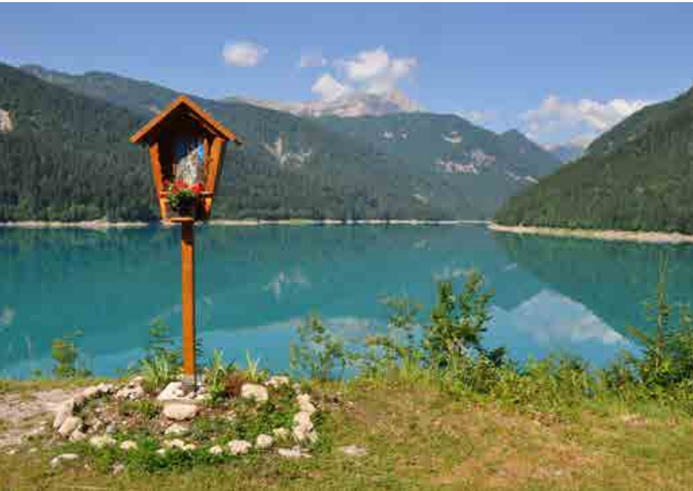
Der Stausee von Lumiei, wenige Kilometer vor Sauris, wurde in den 1940er Jahren errichtet. Die Staumauer mit 130 Metern Höhe war damals die höchste in Europa.
