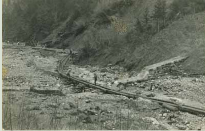
La lisse (risina) sul rio Orteglàs che scende dal monte Tersàdia; Paularo, anni Trenta del secolo scorso.
