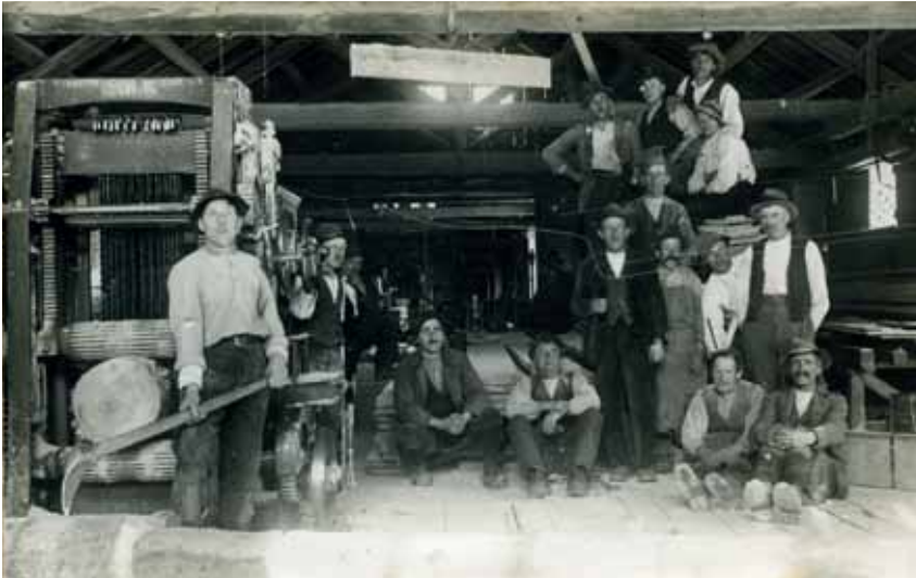
Interno della segheria Tarussio negli anni Trenta del secolo scorso. Sulla sinistra un operaio col sapin e, dietro di esso, la macchina Wollgatter, dotata di lame a movimento verticale, mentre sta tagliando un tronco.
