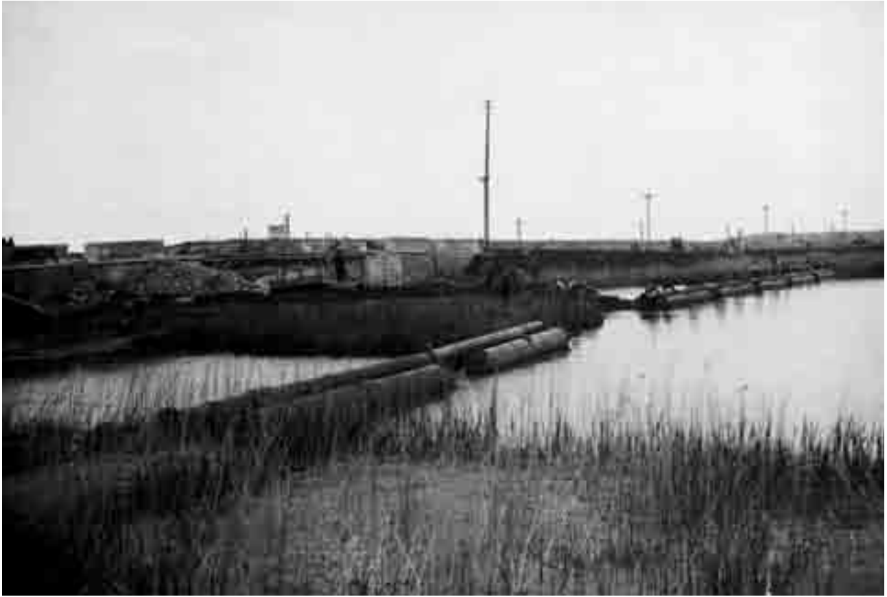
Posizionamento di una condotta di dragaggio nei pressi di San Giovanni di Duino, in provincia di Trieste (1932, Consorzio di Bonifica del Lisert, ora Cinsorzio di Bonifica Pianura Isontina). Su parte dei terreni recuperati dalla palude, oggi è insediato lo stabilimento della Cartiera Burgo S.p.A.
