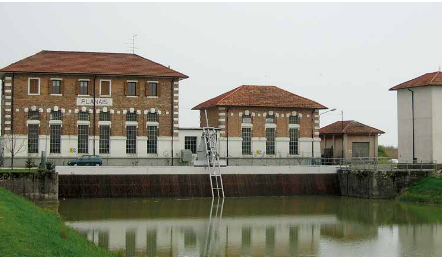
Lo storico impianto idrovoro di Planais del Consorzio di bonifica Bassa Friulana, operativo nell'ambito della zona industriale di S. Giorgio di Nogaro.
