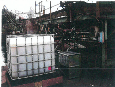
Foto 2. Sistema di nebulizzazione dei nastri 1 - 2 (impianto "Apollo"), con dettaglio della pompa e un contenitore di 1 m 3 per consentire l'aggiunta di aggregante durante la fase di scarico del fossile.
