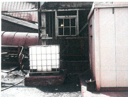
Foto 4. All'esterno della centralina di controllo locale del parco minerale è presente, seppur non attivo, un sistema per l'inserimento di filmanti nell'acqua di irrorazione, con tanto di serbatoio da 1 m 3 (vuoto).
